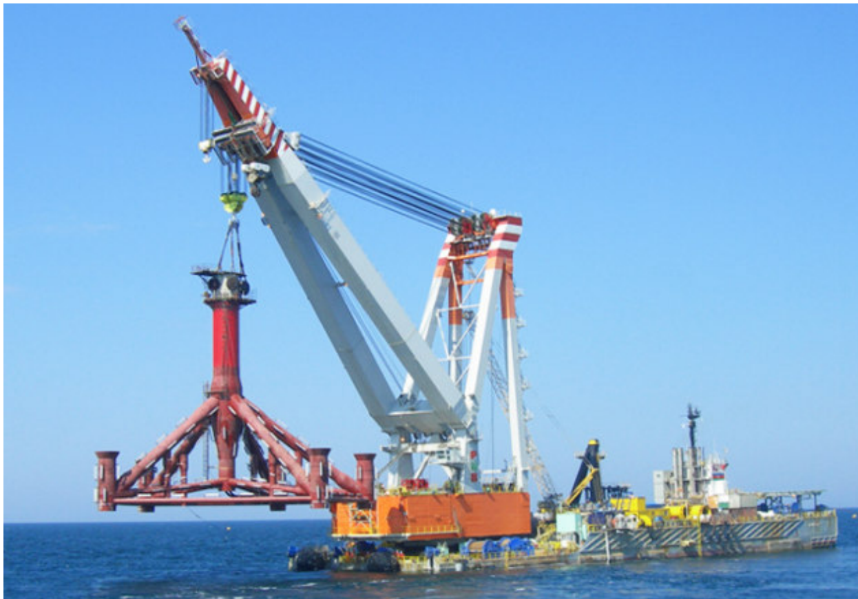
Рисунок 2 - пример установки рамы основания
