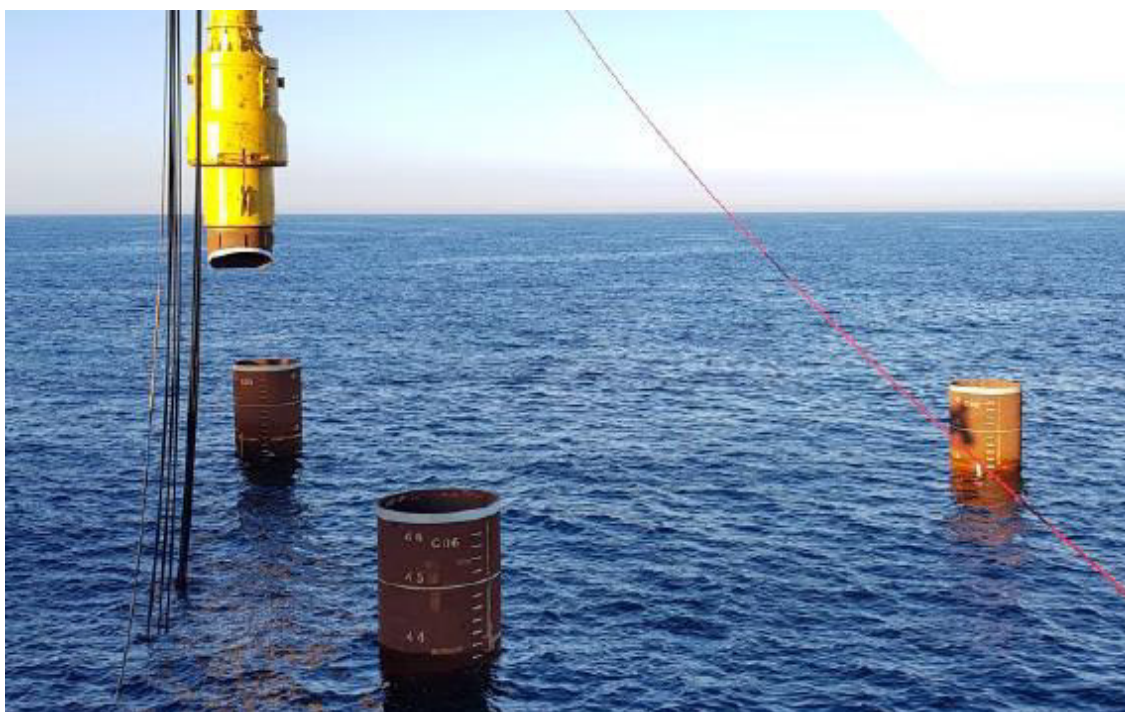
Рисунок 7 - Пример погружения пилотных свай в открытом море
